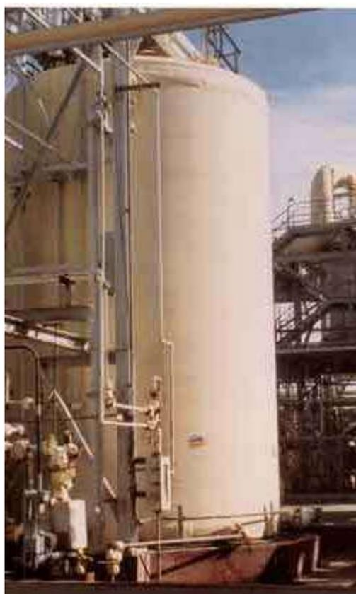
Резервуар из бисфенольно-фумаровой смолы Reichhold, объёмом 80 м<sup>3</sup>, для хранения 37% соляной кислоты, без коррозии эксплуатировался в течение последних 20 лет
